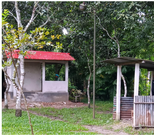
病院敷地に建てられた、新しい警備員詰め所（奥の赤い屋根の建物）。手前は以前の詰め所
